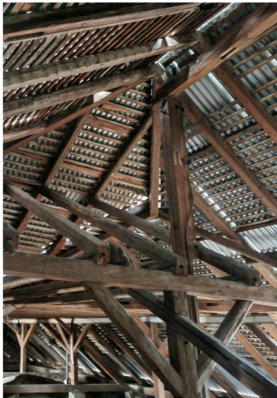
Obr. 7 – Dôsledok zlyhania pripojenia väzných trémov, pokles stípu a vrcholovej väznice: Úsek A-B-C
