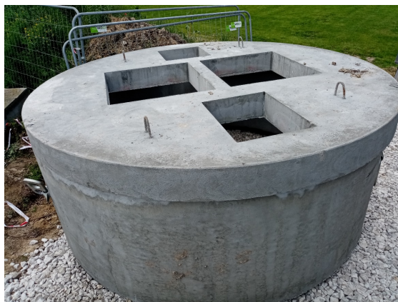
Obr. 1 – Pohľad na konštrukciu počas stavebných prác
