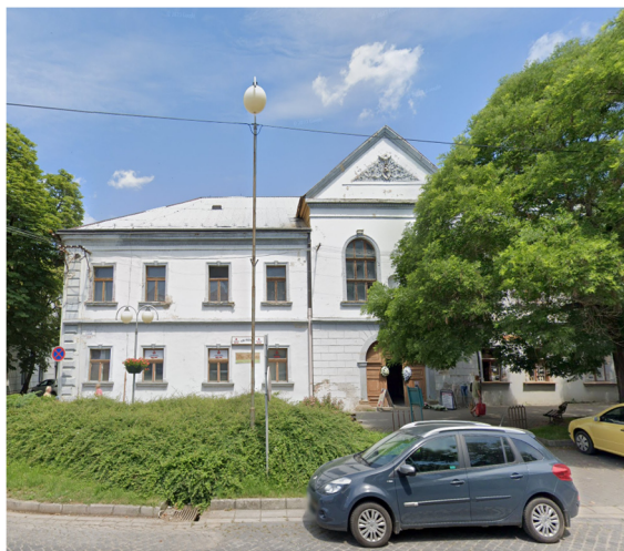
Obr. 1 – Pohľad na priečelnú stranu objektu
