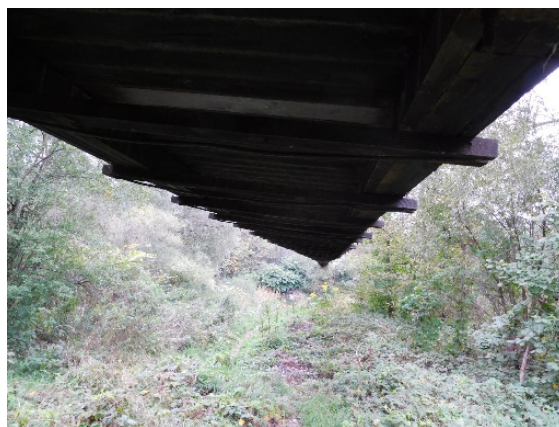
Obr. 2 – Stav pôvodnej konštrukcie
