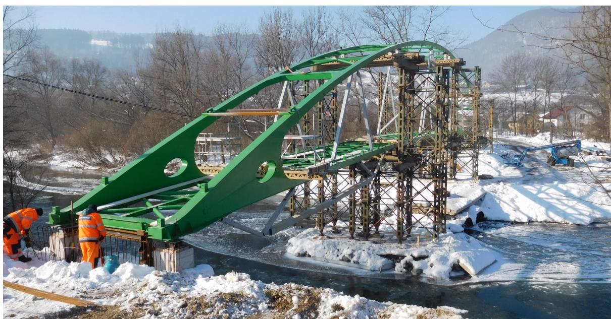
Obr. 3 – Montáž hlavnej nosnej konštrukcie
