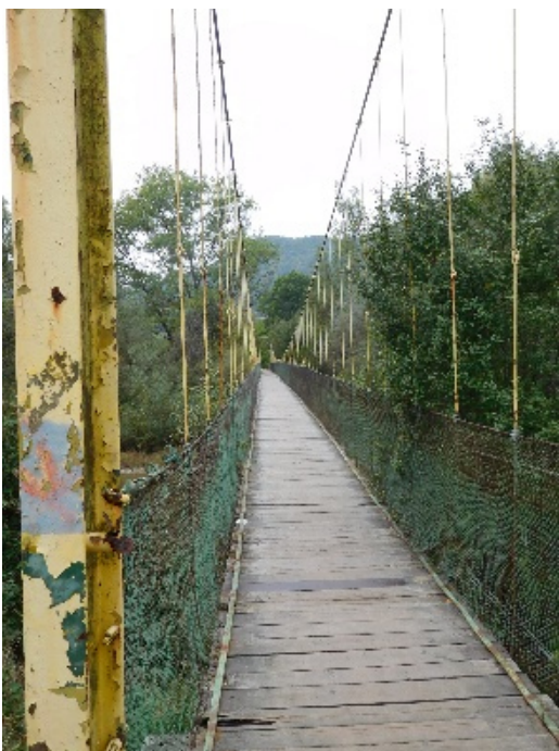
Obr. 1 – Stav pôvodnej konštrukcie
